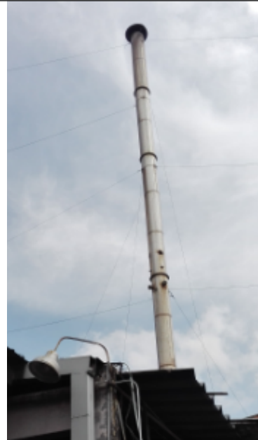
FOTO 10. DUCTO CON PUERTOS DE MUESTREO
